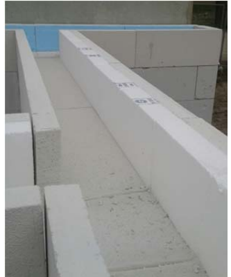
U-Schale mit integrierter Wärmedämmschicht
