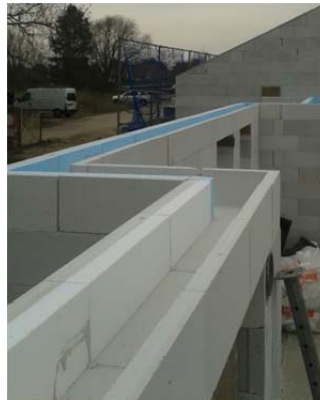
U-Schale mit integrierter Wärmedämmschicht
