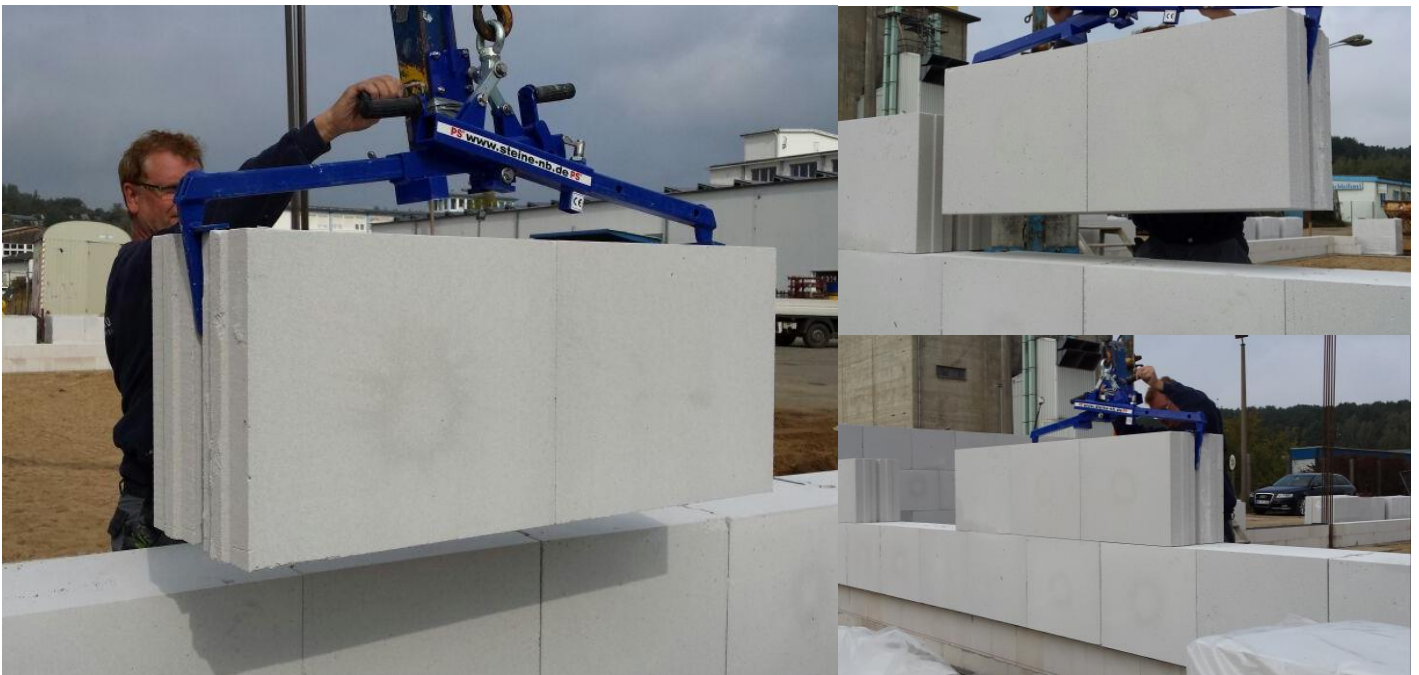
PS*- Planelemente im Doppelpack mit einem Hub 0,6 m 2 - 1,2 lfm in einem Arbeitsgang
